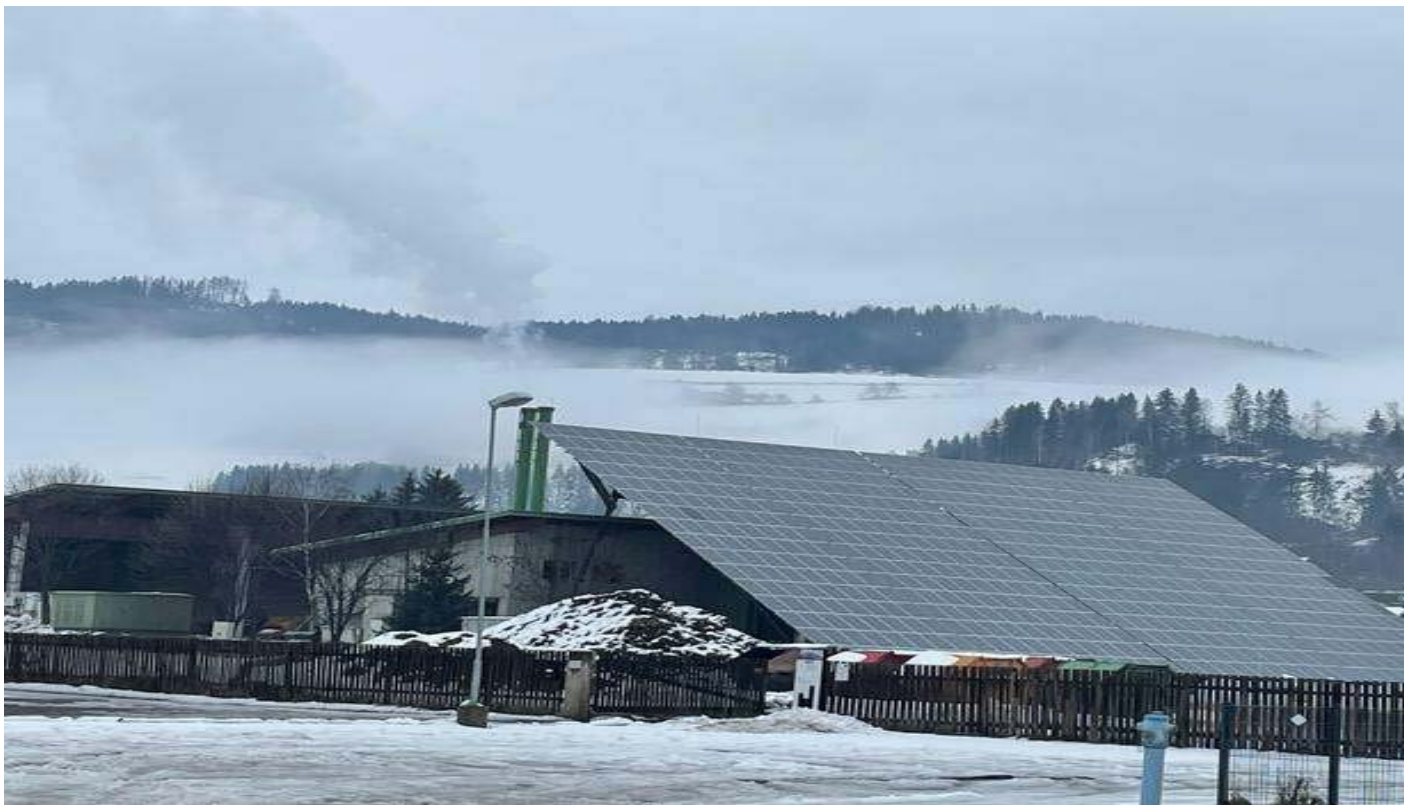
Dauerhafte Lärmbelastung aus dem Heizwerk belastet Anrainer© Josef Fröhlich
